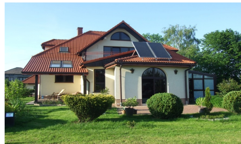
Slika 4 - 2 – Instalacija solarnih toplinskih panela u Niepołomiceu
