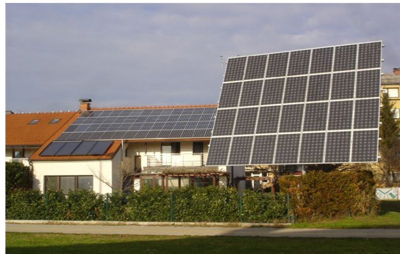
Slika 4-2. Fotografija solarnog krova u Gradu Zagrebu
